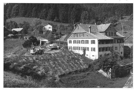
Bild 1. Damm Unterer Weiher mit ehemaliger Mühle Muedsbach – Ansicht von unten. Die Baumaschinen im Bilde sind mit dem Abtrag der Dammkrone beschäftigt. Zusammen mit der neuen Hochwasserentlastung und weiteren baulichen Massnahmen wird damit die Gewähr für die geforderte Sicherheit gegeben sein.
