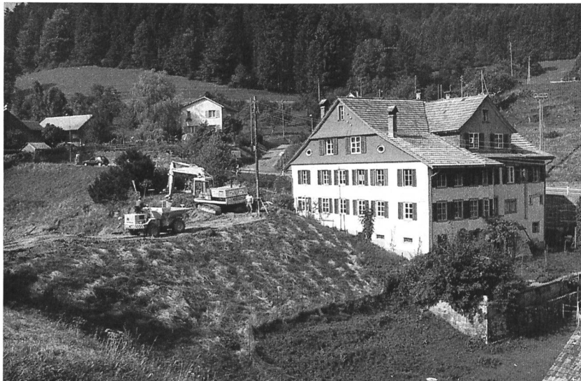
Bild 1. Damm Unterer Weiher mit ehemaliger Mühle Muedsbach – Ansicht von unten. Die Baumaschinen im Bilde sind mit dem Abtrag der Dammkronen beschäftigt. Zusammen mit der neuen Hochwasserentlastung und weiteren baulichen Massnahmen wird damit die Gewähr für die geforderte Sicherheit gegeben sein.
