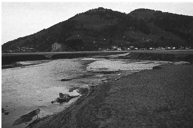
Bild 2. Schlammablagerungen im südlichen Sihlseebecken. Die Minster fliesst hier in einem Canyon durch den abgelagerten Schlamm, der hier 2 bis 3 Meter mächtig ist. Im Hintergrund das Dorf Euthal. Aufnahme im Frühjahr bei abgesenktem Seespiegel.
