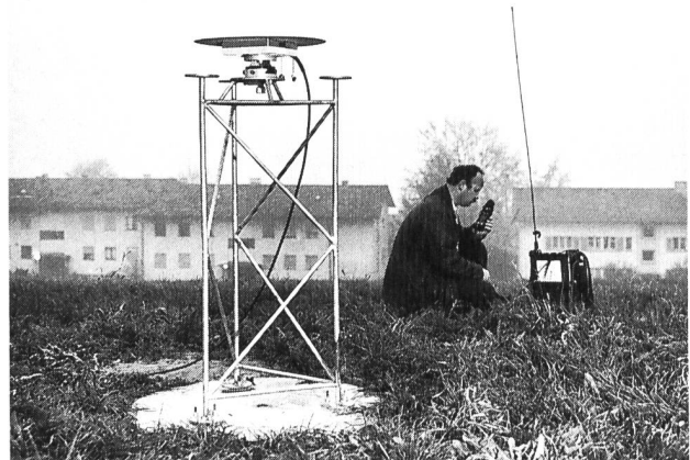
Figure 1. Grâce à une nouvelle méthode de mesurage par satellites et à la demande de la Cédra (Société coopérative nationale pour l'entreposage de déchets radioactifs), l'Office fédéral de topographie a, au cours de l'automne 1988, déterminé au millimètre près la position de 24 points de contrôle se trouvant dans le nord de la Suisse. La photo montre l'antenne dressée au-dessus d'un point de mesurage logé dans le béton (au milieu de la photo). Les signaux reçus qui ont été émis par les satellites sont transmis par câble à un appareil récepteur transportable. Un spécialiste en mesures terrestres (à droite, avec un poste émetteur-récepteur) surveille l'installation de réception pendant le déroulement des mesures.
