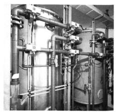
Bild 1, links. Aufbereitungszellen und Trinkwassertank wurden zur Demonstration im Werkgelände aufgestellt. Die Aufbereitungsanlage besteht je nach Bedarf aus zwei bis drei Komponenten, strukturiert nach dem Baukastensystem.
