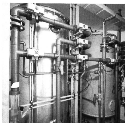
Bild 1, links. Aufbereitungszellen und Trinkwassertank wurden zur Demonstration im Werkgelände aufgestellt. Die Aufbereitungsanlage besteht je nach Bedarf aus zwei bis drei Komponenten, strukturiert nach dem Baukastensystem.
