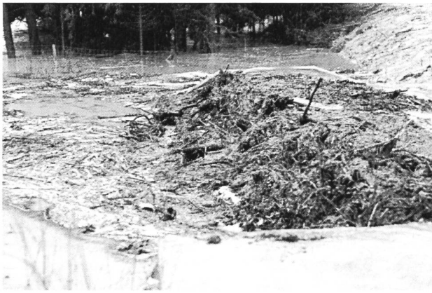
Bild 2. Nach dem Zurückgehen des Hochwassers ist der mit Rechenstäben abgedeckte Beckenentleerungseinlauf etwa einen Meter mit Geschwemmsel überdeckt. Der Haufen enthält wenig Zivilisationsabfall. Das Geschwemmsel, Laub und Äste, schwimmt an der Wasseroberfläche und beeinträchtigt deshalb bei Stau die Entleerung des Beckens nicht.
