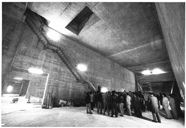
Bild 3. Eine der acht Regenbeckenkammern, die bei Regen als Speicher- und Klärbecken dient.
