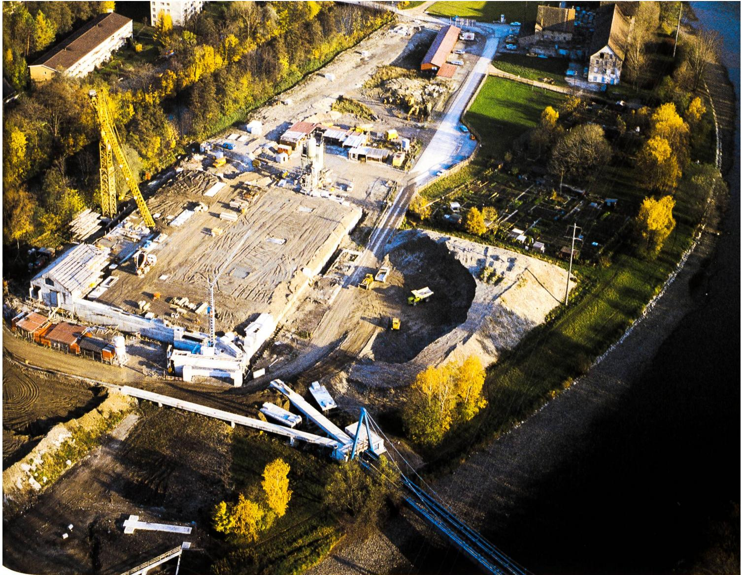
Flugaufnahme der Werdinsel in Zürich mit der Baustelle für das Regenbecken. Die Limmat (rechts im Bild) und der Oberwasserkanal (links oben) fliessen gegen den Betrachter. Am unteren Bildrand verbindet die Rohrbrücke das Regenbecken mit der Kläranlage Werdhölzli. Die Baustelle selbst und die Installations- und Lagerplätze werden wieder begrünt und stehen ab Mitte 1989 als Naherholungsgebiet der Stadtbevölkerung zur Verfügung.
