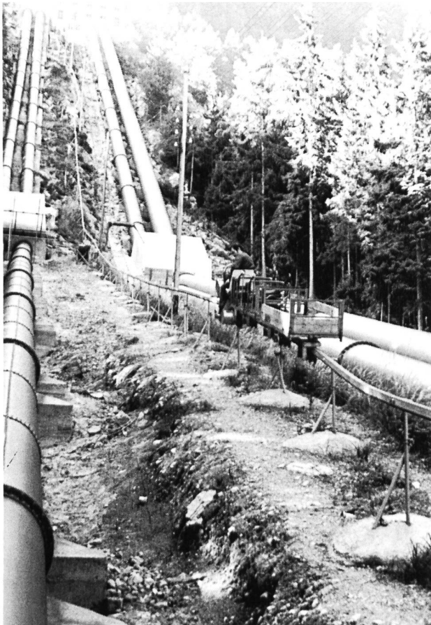
Das Monorack von der Zentrale La Dernier zum Wasserschloss chez le Crêt des Alouettes.
