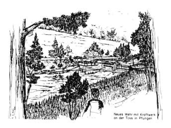
werden. Es erhält zwei je 6 m breite Stahlklappen. Die heutige Staukote wird um 0,5 m erhöht und das Unterwasser um rund einen Meter abgesenkt. Damit entsteht eine Nettofallhöhe von etwa 4 m, die durch eine Rohrturbine ausgenutzt werden soll. Diese Turbine kommt in ein kleines Maschinenhaus am Nordufer zu liegen. Es wird eine Jahresproduktion von 1,5 Mio KWh erwartet.
