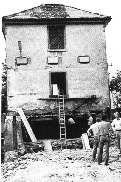
Bild 1. Umbauarbeiten an der Holzschleiferei der Papierfabriken Landquart für die neue Fassung und die Leerschussentlastung.
