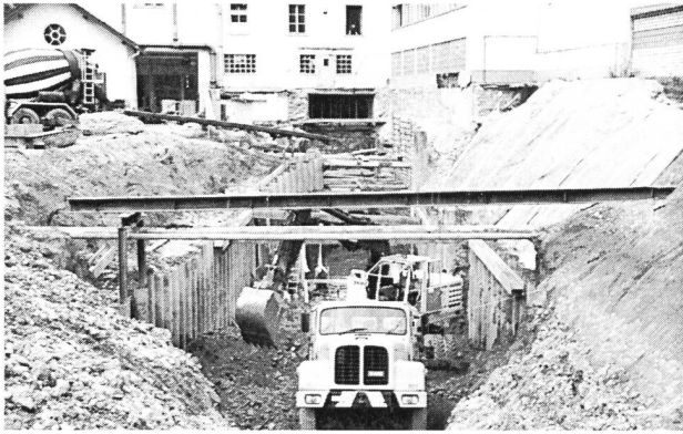
Bild 5. Aushubarbeiten für die neue Zentrale.
