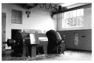
Bild 3. Neue Dotiermaschinengruppe 2430 kW in der Zentrale des Kraftwerkes Dallenwil. Bei der Turbine handelt es sich um die erste einer neuentwickelten Standardbaureihe der Firma Bell AG, Kriens.
