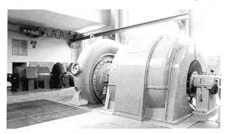
Bild 2. Kraftwerk Dallenwil. Rechts vorne eine der beiden Maschinengruppen von je 7500 kW Leistung, hinten links die neue Dotiermaschinengruppe mit einer Leistung von 2430 kW.
