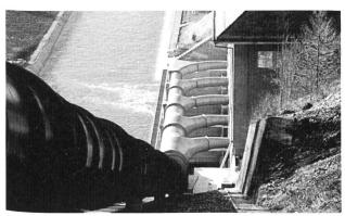
Figure 4. Vue de la partie à l'air libre de la nouvelle conduite forcée de Broc avec son répartiteur et la centrale d'origine.
