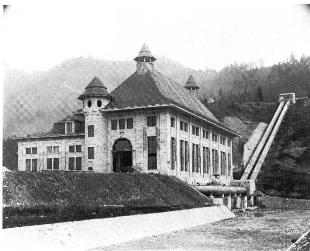
Figure 1. La centrale EEF de Broc avec la conduite forcée double de 1,8 m de diamètre intérieur, avant son remplacement en 1987 par une conduite unique de 3 m.
