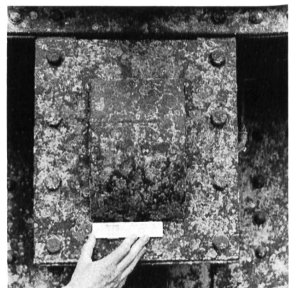
Bild 5. Bewuchs durch einen Süßwasserschwamm am Wehrverschluss.
