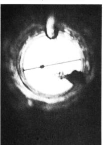
Bild 8. Staumauer Spitallamm. Elektrisches Brenngerät (Eigenkonstruktion) zum Entfernen der rostfreien Drahtverankerungen in den Umkehrlotbohrungen.
