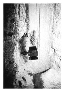
Bild 4. Staumauer Spitallamm. Unverrohrte, versinterte Bohrung mit Loteinrichtungen.
