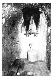
Bild 5. Staumauer Spitallamm. Alte Lotanlage vor dem Umbau mit starken Versinterungen.
