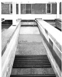
Bild 2. Sulzer-Drainagefilterboden in der Wasserversorgung Zürich.
