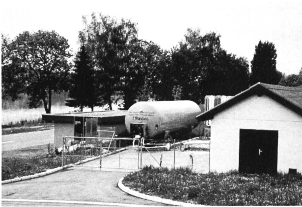
Bild 3a. Fotografische Dokumentation der internen Anlagen. Versorgungsstation mit Sauerstofftank und Betriebsgebäude.
