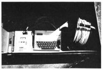
angeschlossen an Hermit-Datensammler, Kontrollmessung mit Kabel-Bild 3, rechts, unten. Ein Feldcomputer ist zwecks Datenübertragung für eine Zwischenauswertung mit dem Datensammler verbunden.
