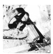
Rührwerke in Schlammstapelgruben von Kläranlagen
