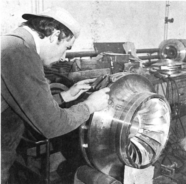
Bild 5. In das EW Feusisberg wird eine Francis-Turbine des abgebildeten Typs eingesetzt.
