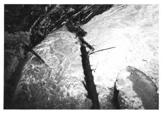
Bild 2. Blick vom Wehr des Kraftwerkes Lüen flussabwärts. Die in der Durchlassöffnung verkeilte Tanne war etwa 20 m lang, der Stamm hatte 70 cm Durchmesser (Juli 1987).
