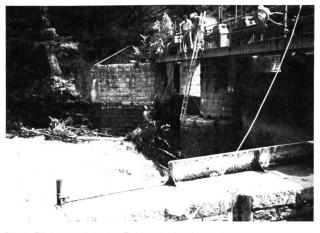
Bild 1. Blick vom Wehr des Rabiusawerkes bachaufwärts. Während des Hochwassers wurden Sand- und Kiesbänke angeschwemmt. Nach dem Zurückgehen des Hochwassers wurde der Sand in der Mitte weggespült; links und rechts bleibt das angelandete Material noch liegen (Juni 1987).
