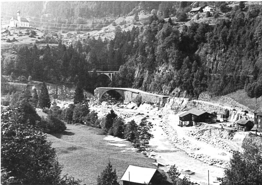
Bild 16. Mehrfach zerstörte Kantonsstrasse unterhalb von Wassen. In Bildmitte befindet sich die Einmündung der Meienreuss. Das Reussbett war nach dem Hochwasser nahezu doppelt so breit. Hohe Stützmauern der Kantonsstrasse (alten Gotthardstrasse) wurden unterspült und stürzten ein. Die Sägerei wurde stark beschädigt. Die Wiederherstellungsarbeiten sind im Gange.
