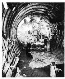
Bild 2. Vom 8600 m langen Druckstollen sind rund 7300 m mit Tunnelbohrmaschinen aufgefahren worden. Das Bild zeigt eine konventionelle Vortriebsstrecke. Bauzustand Sommer 1986
