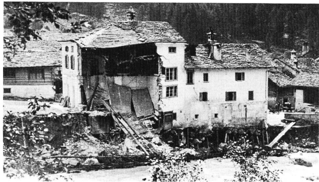
Bild 2. Zerstörte Häuser in Stampa, 1927.
