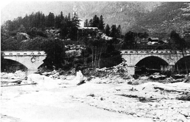
Bild 1. Zerstörte Strassenbrücke über die Maira unterhalb Stampa, 1927.
