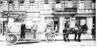
Fig. 6. Entleerung des Aschengefässes beim Dreiteilungssystem.
