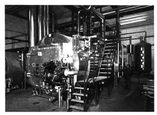
Bild 1. Dreizugkessel in einer Industrieenergiezentrale, ausgerüstet mit einem Brenner zum wahlweisen Betrieb mit Schweröl oder Erdgas.
