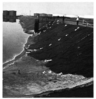
Bild 4. Blick in die bereits fertiggestellte, provisorische Deponie Papageienschnabel, die die Schlammklasse 4 aufnehmen wird. (Foto B. Zarn)
