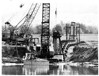
Bild 2. Der Maindüker bei der Ebertbrücke Aschaffenburg. Montage der Stahlrohre zu einem Dükerbündel; Anbringen des polypropylenbewehrten Betonmantels.
