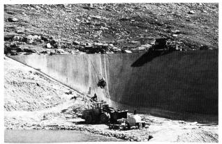
Bild 9. Das Überlaufbauwerk.
