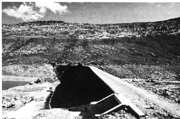
Figure 10. L'appui droit de la digue avec déversoir.
