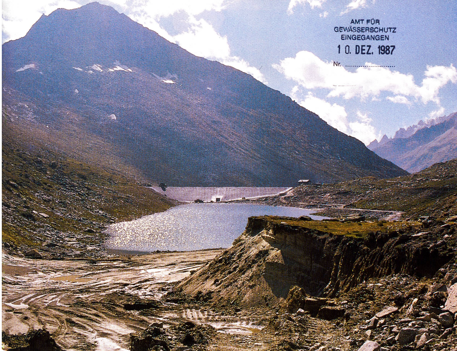
Staudamm Vordersee, 2360 m ü.M., für die Wasserversorgung im Aletschgebiet. Im Vordergrund die Entnahmestelle für das Dammbaumaterial. Links hinter dem Damm das Eggishorn. Foto: Daniel Quinche
