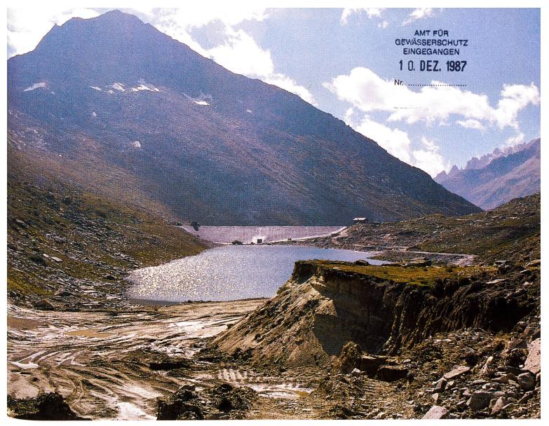
Staudamm Vordersee, 2360 m ü.M., für die Wasserversorgung im Aletschgebiet. Im Vordergrund die Entnahmestelle für das Dammbaumaterial. Links hinter dem Damm das Foto: Daniel Quinche Eggishorn.
