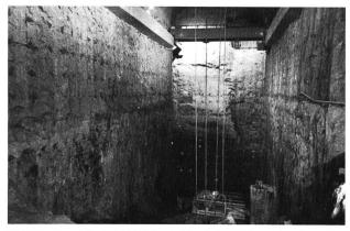
Bild 4. Kraftwerk Jostedal (1 Peltonturbine à 275 MW). Ausbruch der Maschinenkaverne (37000 m³). Die Betonträger der Kranbahnen sind nicht abgestützt, sondern nur mit Felsanker gesichert. Die systematische Ankerung der Kavernenwände ist erforderlich, um den gefährlichen Bergschlag zu verhindern (Sprödbruch infolge hoher Sekundärspannungen).
