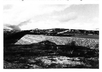
Bild 1. Kraftwerk Sy-Sima (2 Peltonturbinen à 310 MW). Steinschüttdamm Sysen: maximale Höhe 81 m, Schüttvolumen 3,64 Mio  $\rm m^3$ , Nutzvolumen 400 Mio  $\rm m^3$ .
