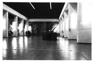
Bild 3. Kraftwerk Orkla. Maschinenkaverne Brattset (2 Peltontubinen à 40MW): unverkleidete Seitenwände der Maschinenhalle, mit Spritzbeton verkleidetes Gewölbe.
