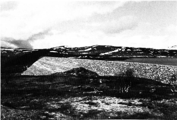
Bild 1. Kraftwerk Sy-Sima (2 Pelton-turbinen à 310 MW). Steinschüttdamm Sysen: maximale Höhe 81 m, Schüttvolumen 3,64 Mio m 3 , Nutzvolumen 400 Mio m 3 .
