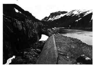
Bild 2. Kraftwerk Aurland I (450 MW). Typische Hochwasserentlastung einer norwegischen Talsperre (Speicher Viddalsvatn): seitliche Sammelrinne, betonierter Überfall, Rinne und Ablaufstollen im unverkleideten Fels.
