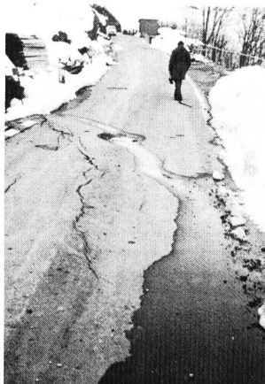
Figure 8. Fissures dans la couverture d'une route.
