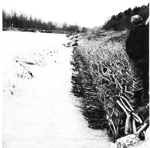
Bild 2. Zum Schutz gegen die hochgehende Thur werden die Ufer seit altersher mit Weiden verbaut. Bei der Wippenwuh bei Pfyn (kurz nach dem Einbau) haben die Weiden noch nicht wieder ausgeschlagen.
