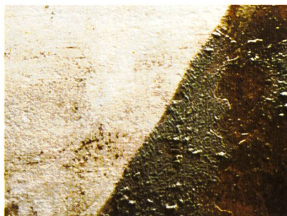
Intensive Reinigung bis zum blanken Metall blanken Beton
