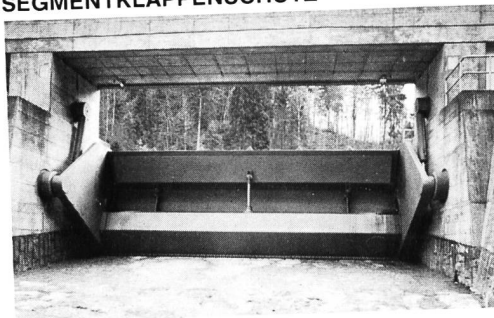
SEGMENTKLAPPENSCHÜTZ
