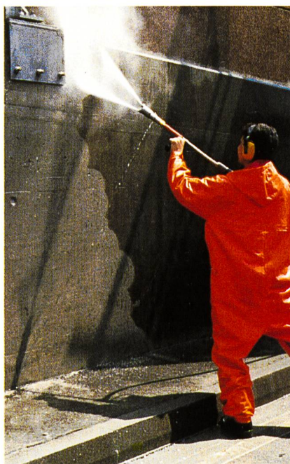
Intensive Reinigung bis zum blanken Metall blanken Beton
