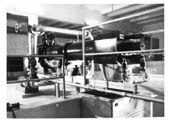
Bild 1. Strainpress Typ SP-4. Kläranlage Lützelau/Schweiz.
