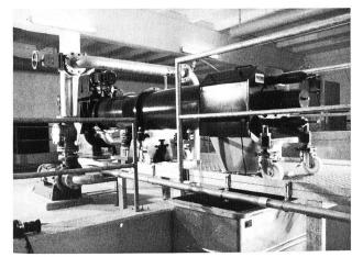
Bild 1. Strainpress Typ SP-4. Kläranlage Lützelau/Schweiz.
