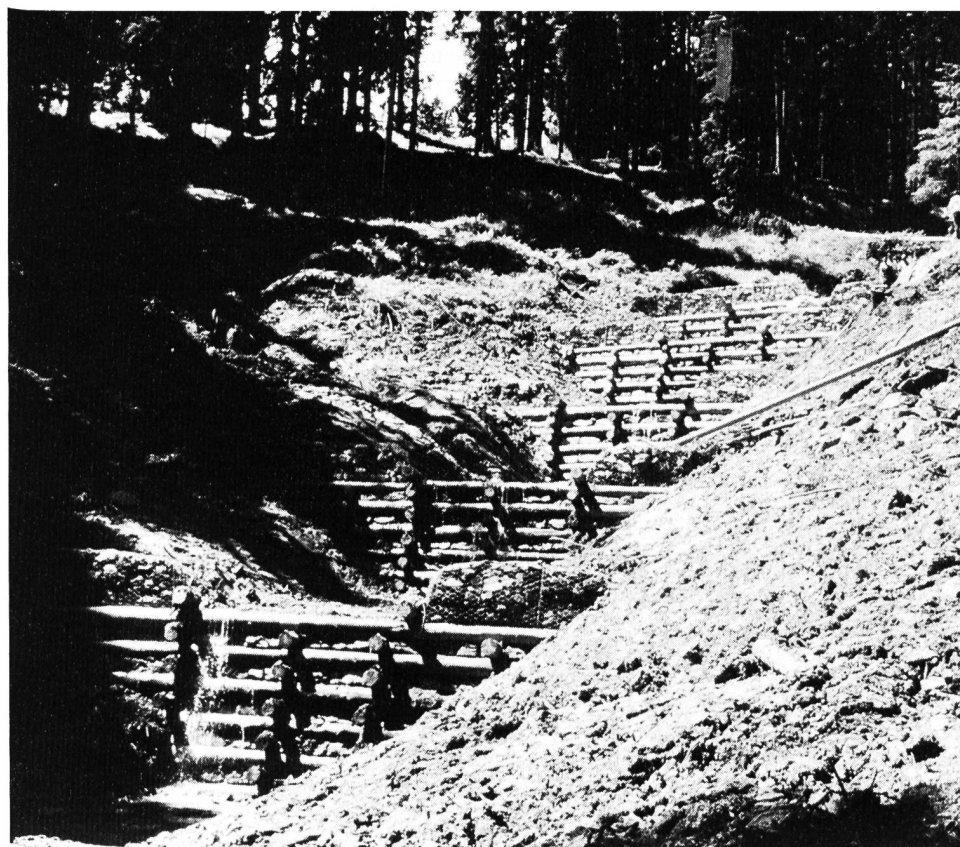
Bild 1. Typische Holzkastensperren der Gamser Wildbäche. Diese Neukonstruktionen unterscheiden sich nicht von den in früheren Jahrzehnten erstellten Sperren mit Ausnahme der Sperrenflügel, die damals aus Natursteinblöcken aufgebaut wurden.
