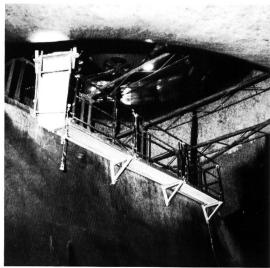
Bild 1, links. Die Montage und der Transport des Materials des Gerüstbodens geschieht durch die einzige Zugangstüre von der Spirale ins Saugrohr.
