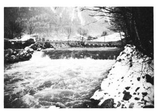
Bild 5. Ein Flusswehr von dieser Höhe bietet für die Laichwanderung von Bach- und Seeforellen ein unüberwindbares Hindernis (Wehr bei Ennenda GL).
