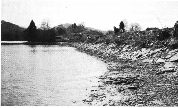
Bild 8. Wasserseitige Böschung des Norddamms während der Rodungsarbeiten.
