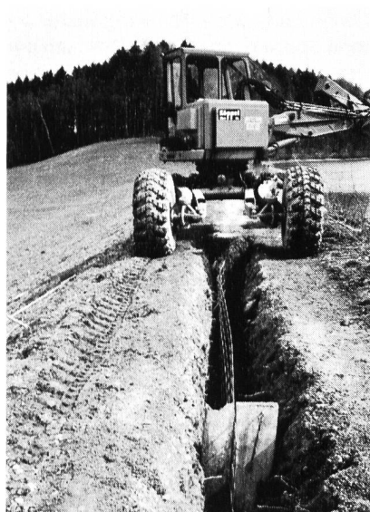
Bild 5. Einbau der Trennwand beim Norddamm.
