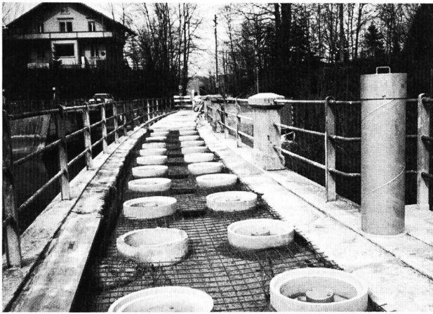
Bild 6. Mauerkrone der östlichen Abschlussmauer mit Kontrollschächten.
