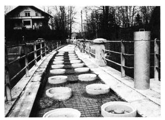
Bild 6. Mauerkrone der östlichen Abschlussmauer mit Kontrollschächten.
