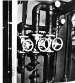
Bild 2. Teilansicht der mit BOA-Ventilen aus Meehanite-Guss ausgerüsteten Heizungsanlage der Forschungsstation. (Quelle: KSB Frankenthal).
