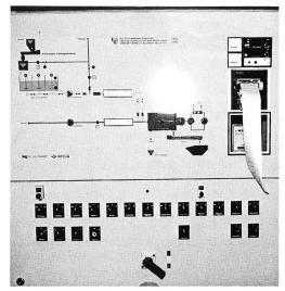
Bild 4. Automatische Flockungsmittel-Aufbereitungsanlage (Fotos H. Letsch, AFU GR). Bild 5. Steuerschrank mit Blindschaltbild.
