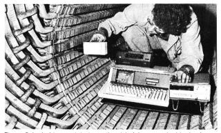
Figure 5. Le bobinage statorique vibre à la fréquence double du réseau lorsque le blocage mécanique dans les encoches est insuffisant. Ceci à pour conséquence une dégradation de l'isolation. Pour cette raison un contrôle de calage du bobinage à intervalles réguliers s'impose. Une nouvelle méthode, basée sur une mesure spéciale des vibrations, permet de réaliser ce contrôle de manière fiable, l'influence de l'opérateur étant éliminée. (Photo BBC Brown Boyeri)
