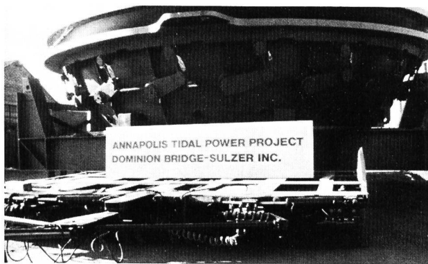
Bild 7. Eintreffen des Turbinenstators auf der Baustelle.
