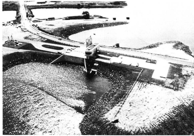
Bild 3. Kraftwerksgebäude in Annapolis Royal: kompakt und weitgehend unter Wasser.
