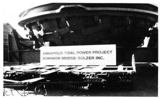
Bild 7. Eintreffen des Turbinenstators auf der Baustelle.
