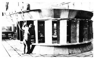
Figure 2. Montage du redresseur pour la turbine Francis destinée à «Song Loulou» (Cameroun), aux Ateliers de Constructios Mécaniques de Vevey.
