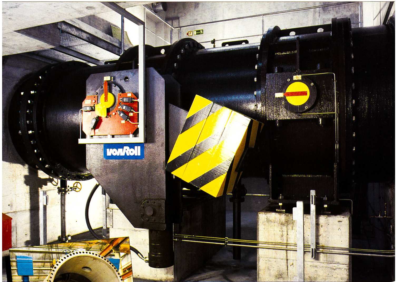
Drosselklappen als Turbinenabschluss im Kraftwerk Spiez der Bernischen Kraftwerke AG, Schweiz
