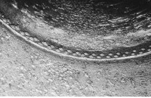
Bilder 1 und 2. Korrosion in einer 50jährigen Druckleitung. In diesem Ausmass bewirkt die Korrosion eine spürbare Erhöhung der Energieverluste und auch bereits eine Reduktion der Festigkeit. Eine kurzfristige Sanierung erwies sich in diesem Fall als notwendig.
