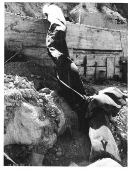
dabei übersehene Änderung im Druckstossverhalten des Systems führte zum Platzen eines Leitungsstranges mit erheblichen Folgeschäden.
