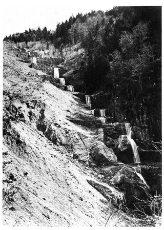
Bild 2. Der Gruonbach bei Flüelen wurde zum Schutz der Gotthardbahn seinerzeit noch mit den damaligen Mitteln verbaut. Seilbahnen, Strassen und Helikoptertransporte standen noch nicht zur Verfügung. Heute ist der ganze Hang dicht bewaldet. Die alten Verbauungen müssen schrittweise durch Betonkonstruktionen ersetzt werden.
