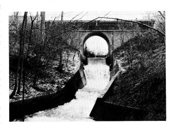
Bild 1. Beim Kleinkraftwerk Roggwil wird ein natürlicher Gefällssprung von 10 m der Langeten bei der Güllenbrücke genutzt.
