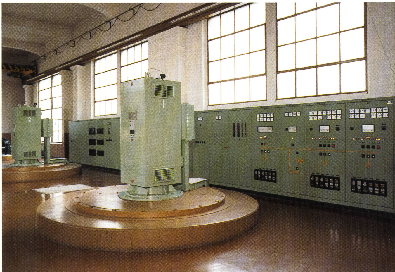
Synchrongenerator 710 kVA, 525 V, 1500 U/min und Getriebe 170/1500 U/min, angetrieben mit Kaplanturbine
