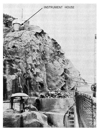
Figure 4. Accélérographe en rive gauche du barrage de Pacoïma après le séisme (tiré de doc. Caltec).
